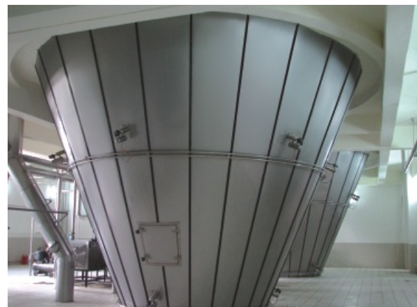
奶粉工程进风部分 Air intake system for milk powder
